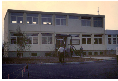
Neubau in Ruit, 1970. An der Ecke Brunnenwiesenstraße und Reinäckerstraße entstand die erste Ausbildungsstätte. Aus der Tür kommen Ruitler Gemeinderäte nach einer Besichtigung.
