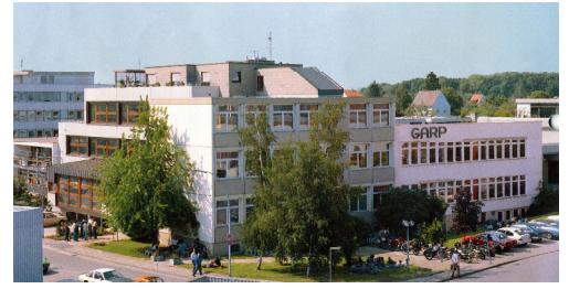
Die Gebäude der GARP in Ruit, 1981. Bereits 1976 war das Gebäude erweitert und aufgestockt worden. Die steigenden Teilnehmerzahlen und der moderne Maschinen- und Gerätepark brauchten Platz.
